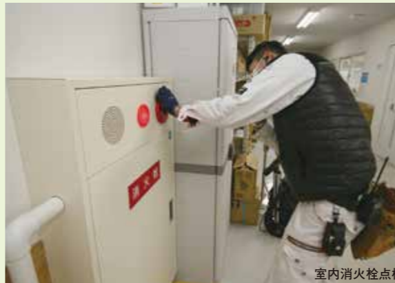
室内消火栓点検
