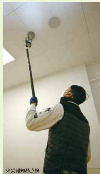
火災報知器点検
